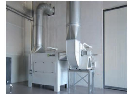
1-3-4. stazioni MSF 57/35 in diverse applicazioni | 2. doppia unità KOMBİ 6N OM con propulsore esterno, portata 40000 nmc/h | 5. singola unità KOMBİ 6N OM con propulsore esterno, portata 18000 nmc/h
