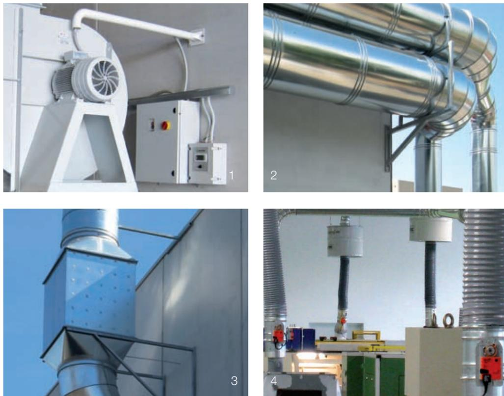
1. quadro inverter con adiacente quadro di regolazione dotato di PLC | 2. doppia linea di aspirazione | 3. silenziatore assorbitivo MSA per condotto di espulsione, portata 20000 nmc/h | 4. serie di serrande servocomandate per l'intercettazione del collegamento con utenza non attiva
